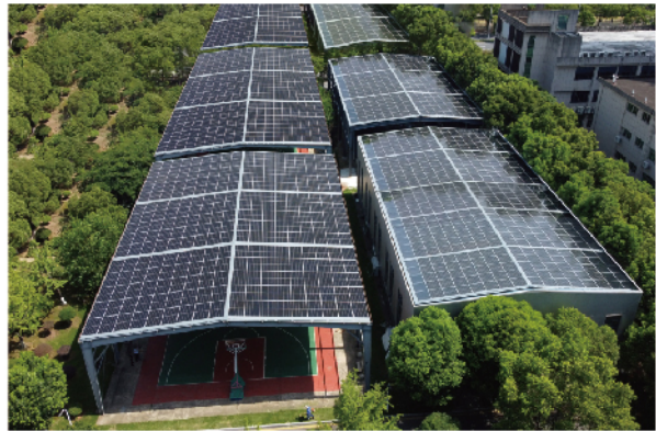
国网江西电科院江西“源网荷储”光伏项目
