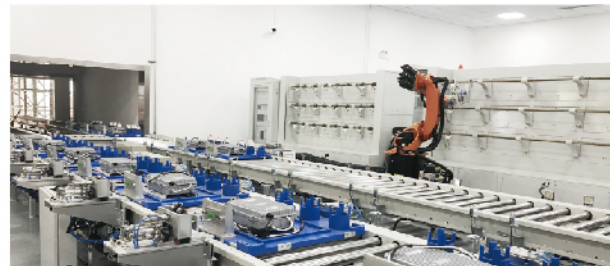
冀北电力公司北戴河电网中心“四线一库一系统”项目
